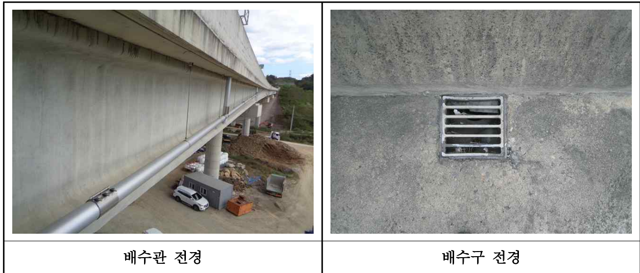
【사진 26.3.46】 배수시설 전경
