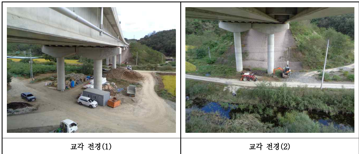
【사진 26.3.35】 교각 전경
