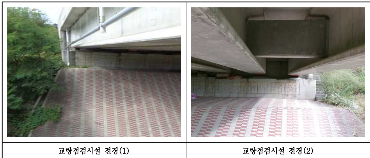
【사진 26.3.50】 교량 점검시설 전경
