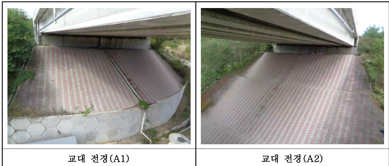
【사진 26.3.33】 교대 전경
