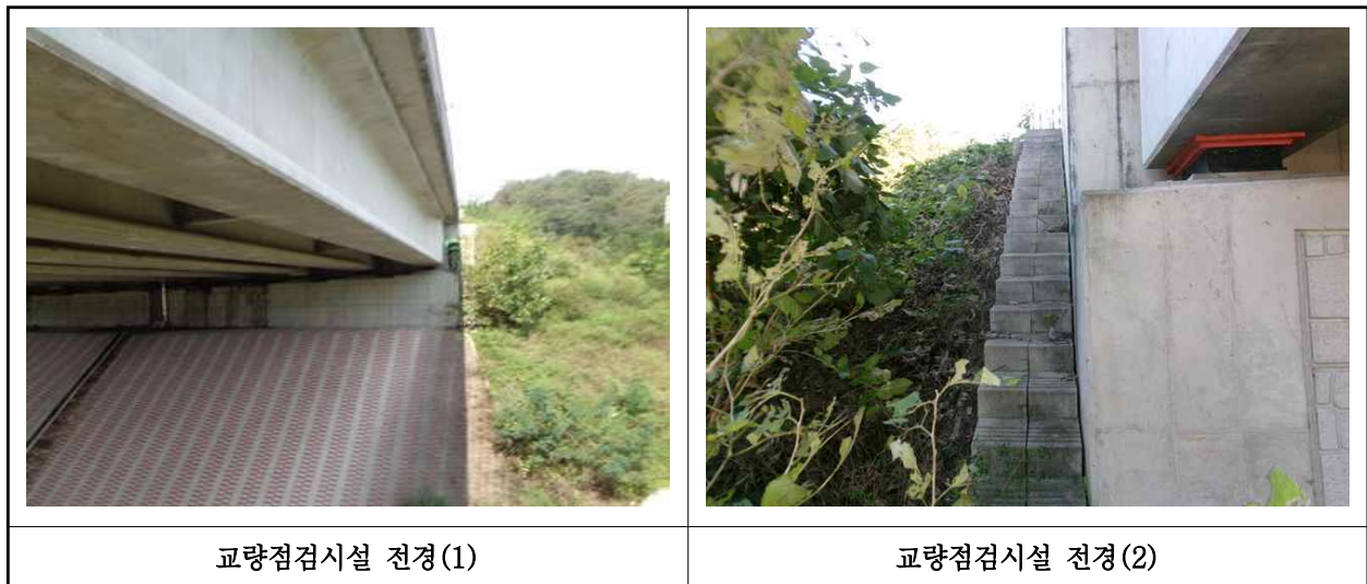
【사진 26.3.25】 교량 점검시설 전경
