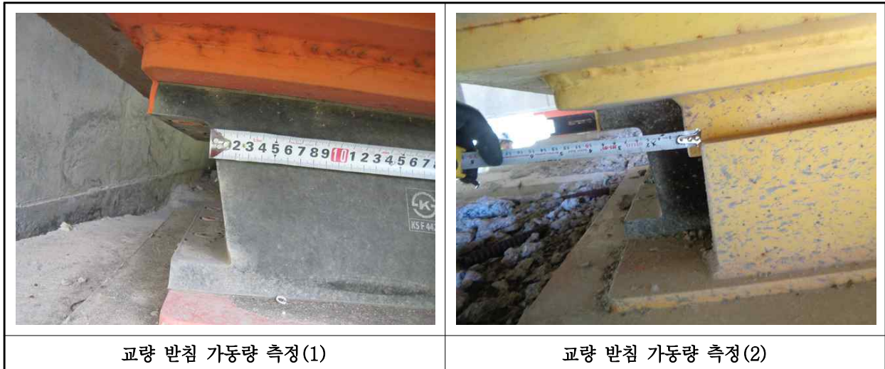
【사진 26.3.40】 교량받침 이동량 측정
