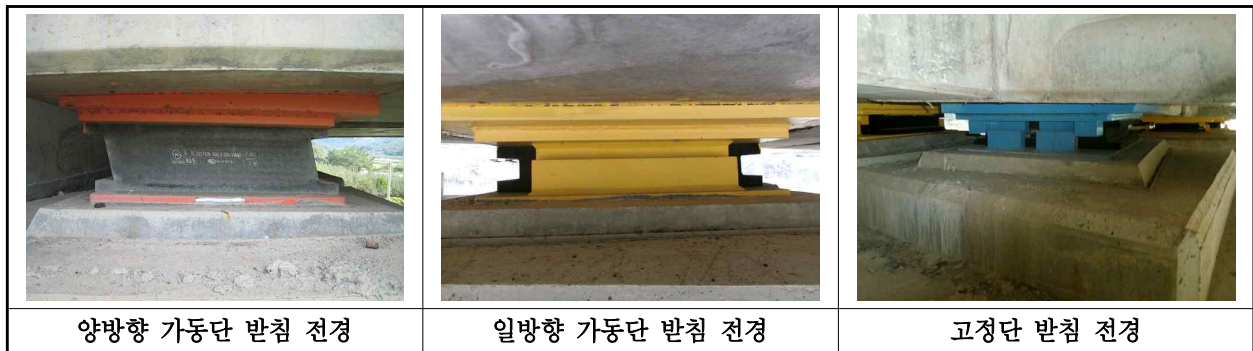
【사진 26.3.37】 교량받침 전경
