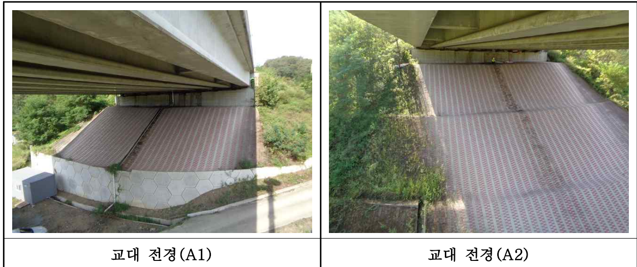
【사진 26.3.8】 교대 전경
