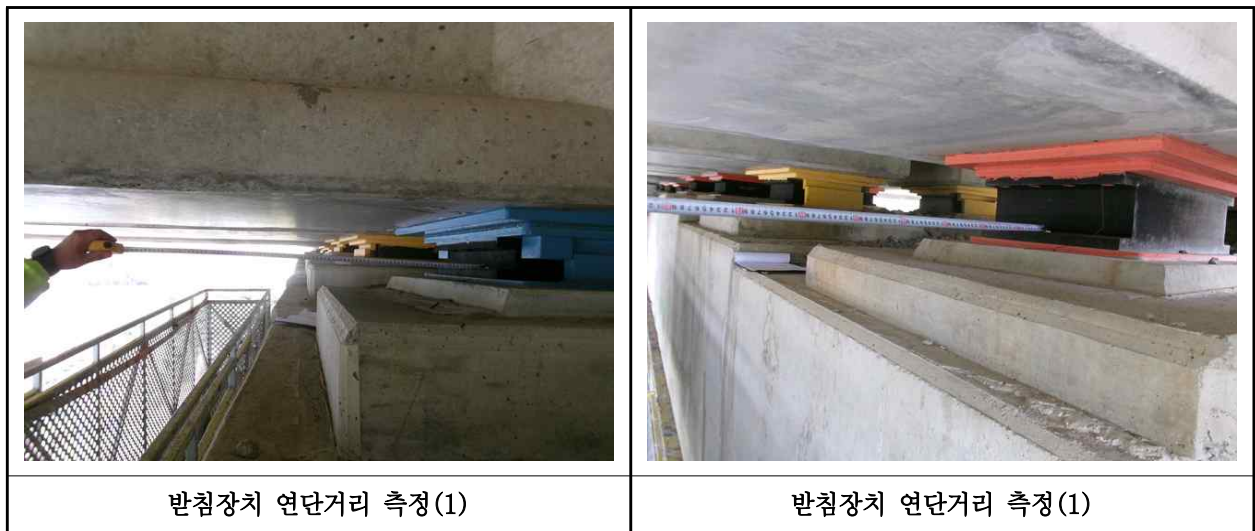
【사진 26.3.39】 교량받침장치 연단거리측정
