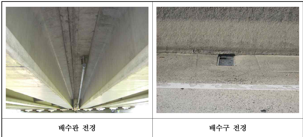
【사진 26.3.21】 배수시설 전경
