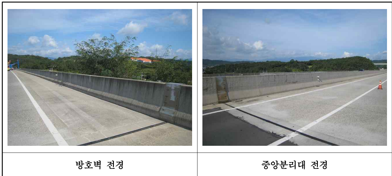
【사진 26.3.23】 방호벽 및 중앙분리대 전경
