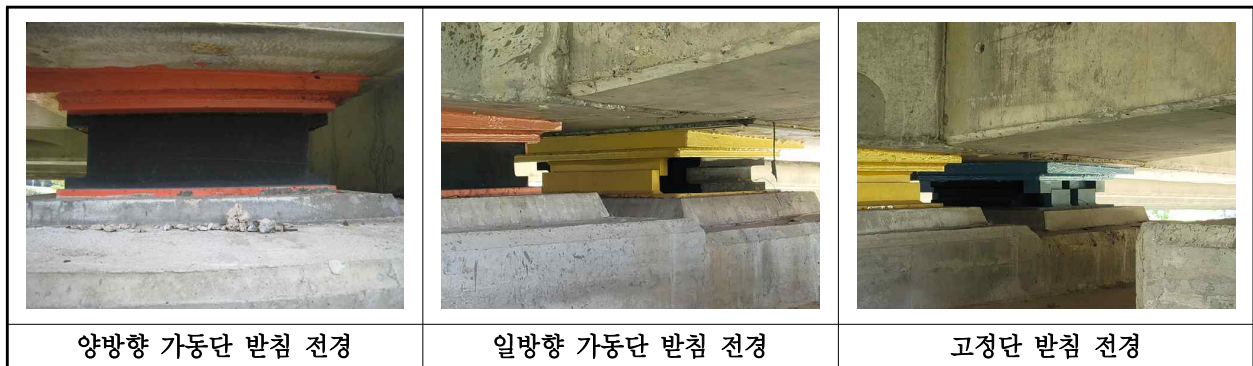
【사진 26.3.12】 교량받침 전경
