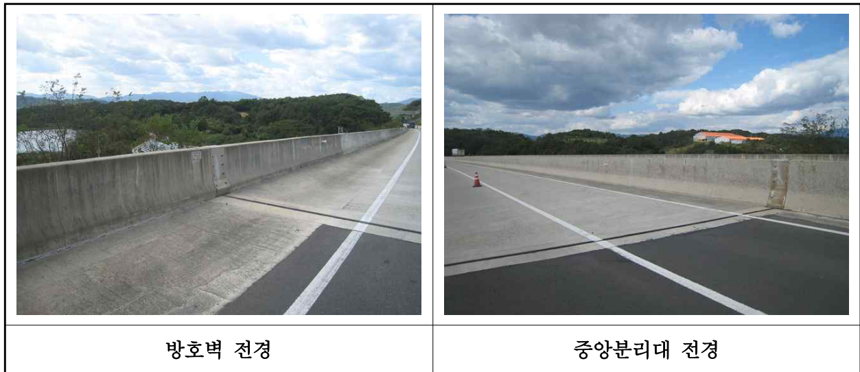
【사진 26.3.48】 방호벽 및 중앙분리대 전경
